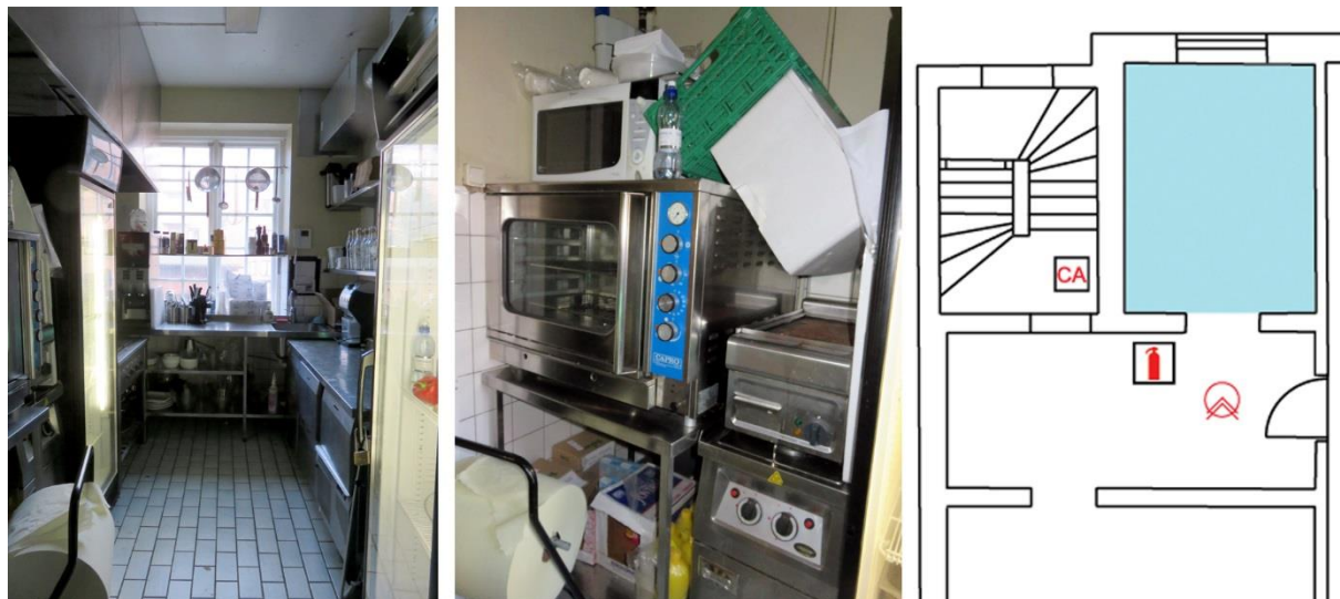
Figur 9.1. Bilder från köket och ritning över köksutrymmet med placering av detektor och handbrandsläckare utanför köket. Vid platsbesök fanns mycket brännbart material i direkt anslutning till ytor som kan vara heta.
