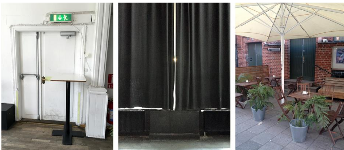
Figur 10.1. På bilden visas bord som blockerar nödutgången på andra våningen, draperier som skymmer vägledande markering i stora lokalen och utemöbler som försvårar utrymning genom varuintaget.
