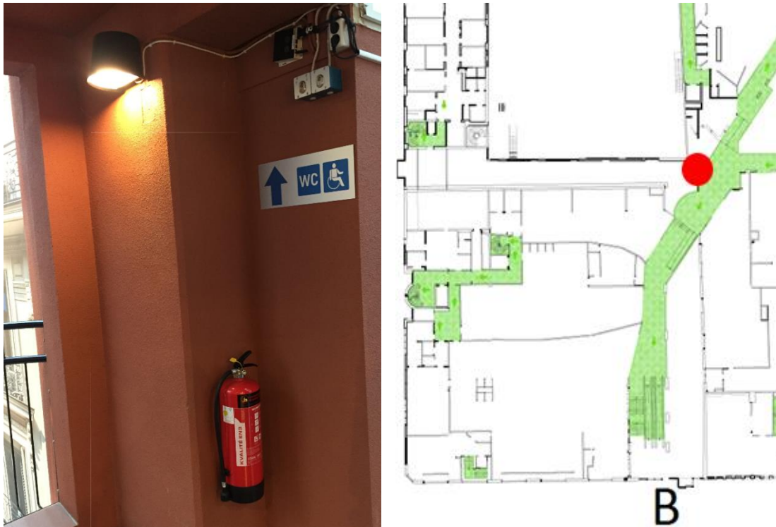
Figur 6. Handbrandsläckare på plan två utan varselskylt.
