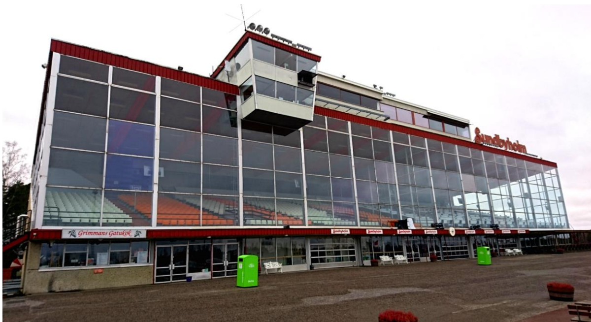
Figur 1. Översiktspå bilden av travbanans läktarbyggnad.
