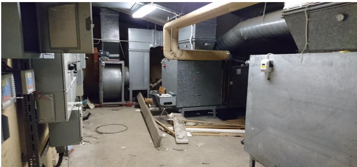
Figur 7. Översiktsbild av fläktrum 1.
