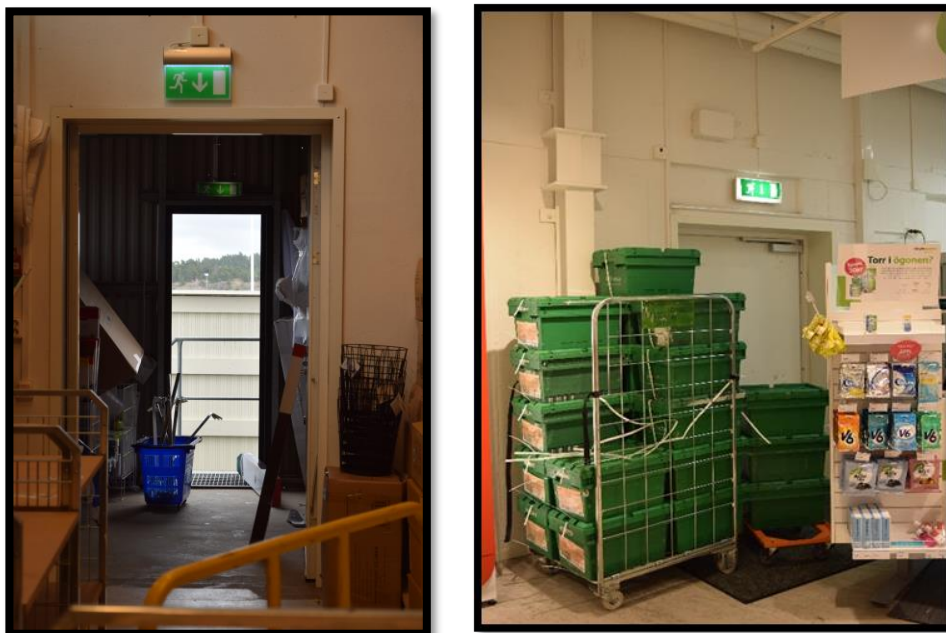
Figur 12. Blockerade utrymningsvägar på Jysk och Lloyds apotek.
