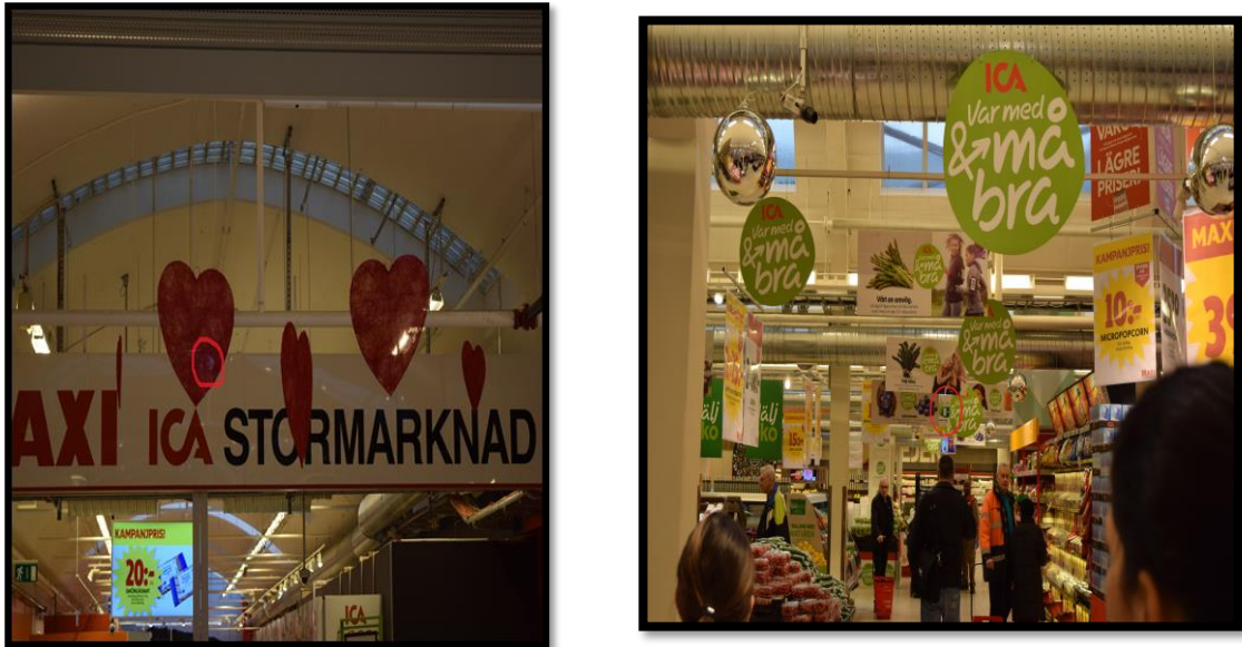
Figur 11. Vänstra bilden visar hur dekorationen i galleriagången blockerat utrymnings skylt till närmaste utrymningen medan den högra bilden visar att både färgen och längden på reklamskyltarna förhindrar synen på utrymnings skyltarna.
