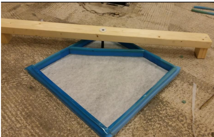
Figur 19. Form för provgjutning med mätrör för RF-givare.
