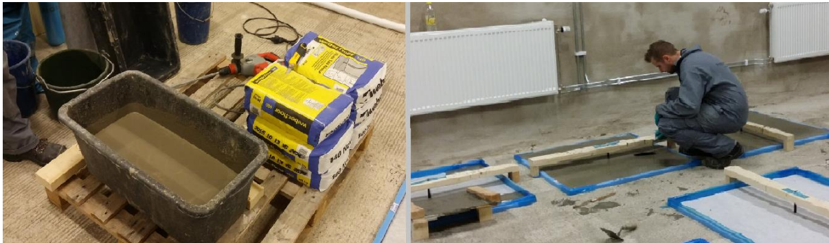
Figur 24. Till vänster visas blandad avjämningsmassa i stort kärl. Till höger bearbetas ytan med en murslev innan gjutningens tjocklek kontrolleras.
