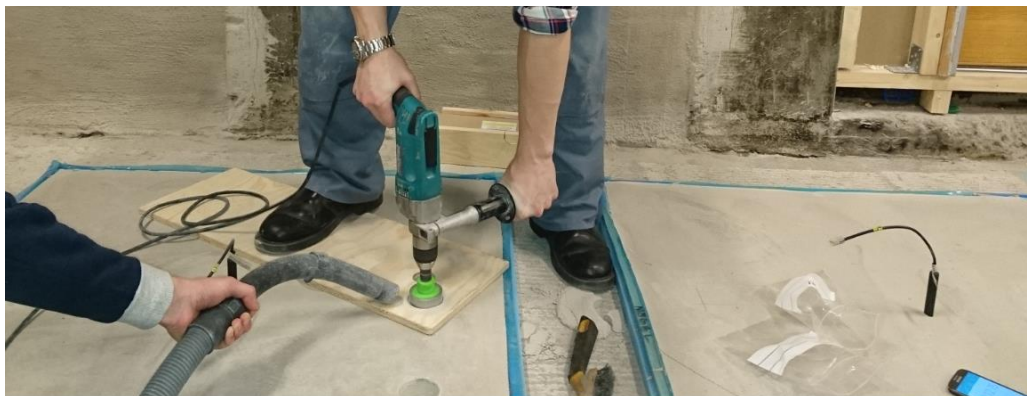
Figur 27. Borrning under de första 20 sekunderna med mall.
