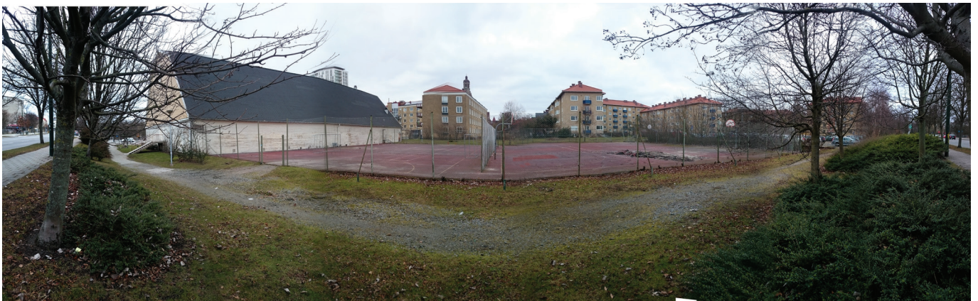
3. Kv Priorn - Övergivna och nedgångna tennisbanor
