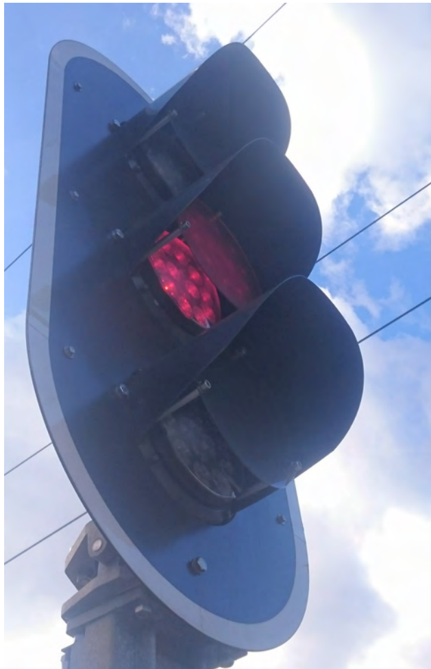
Figur 17 Foto från Roslagsbanan, Solfilm monterad framför linsen (Foto Per Ericsson)
