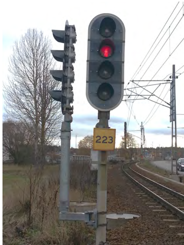
Figur 14 Provsignal monterad på befintlig stolpe (Foto Andreas Mårtensson)
