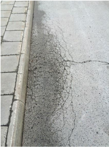
Figur 3. Krackelering eller sprickor i hjulspår? (Kvarnby)
