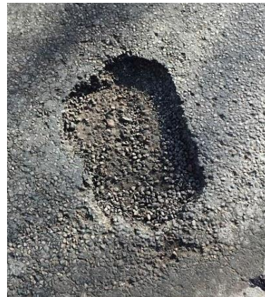
Figur 11. Slaghål (Erikslust)
