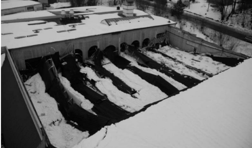
Figur 4.5. Bild efter att stora delar av taket på byggnaden i Höör kollapsat (Blåder & Nilsson, 2011).
