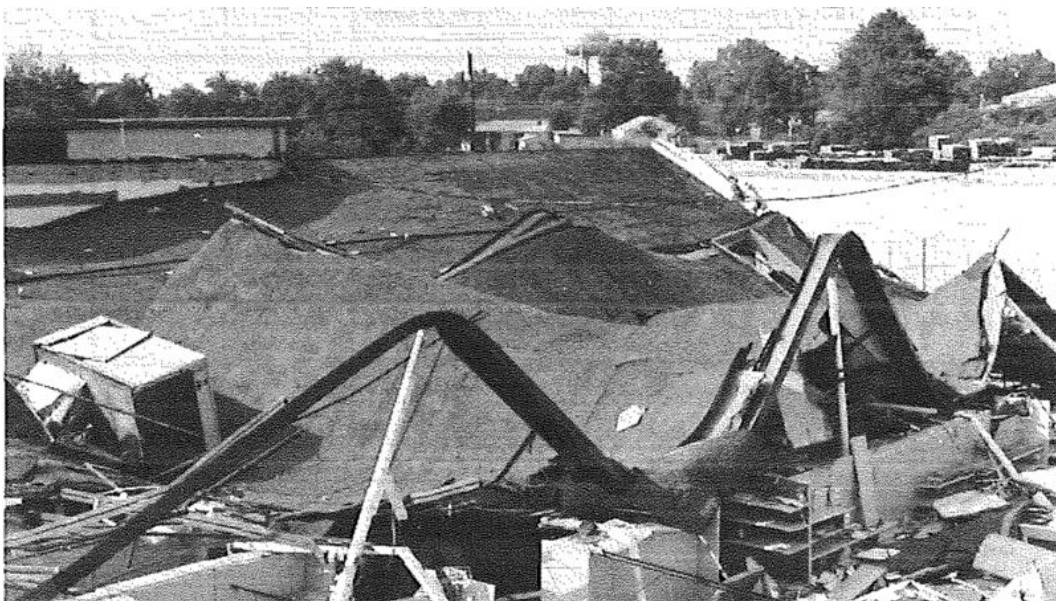
Figur 4.7. Vy över byggnaden i Bolivar där taket kollapsat fullständigt (Bell & Parker, 1987).
