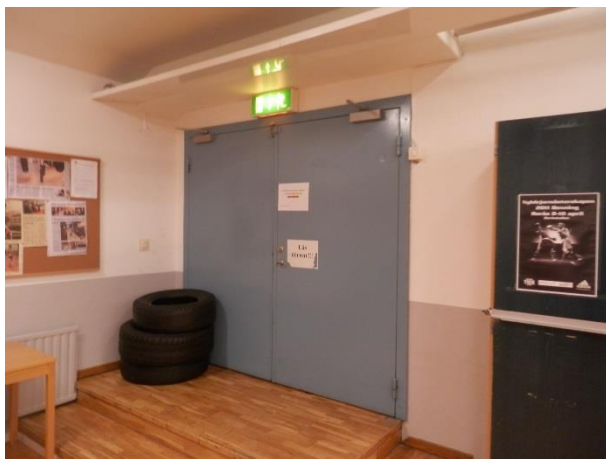
Figur 41. Hinder placerade framför utrymningsväg.
