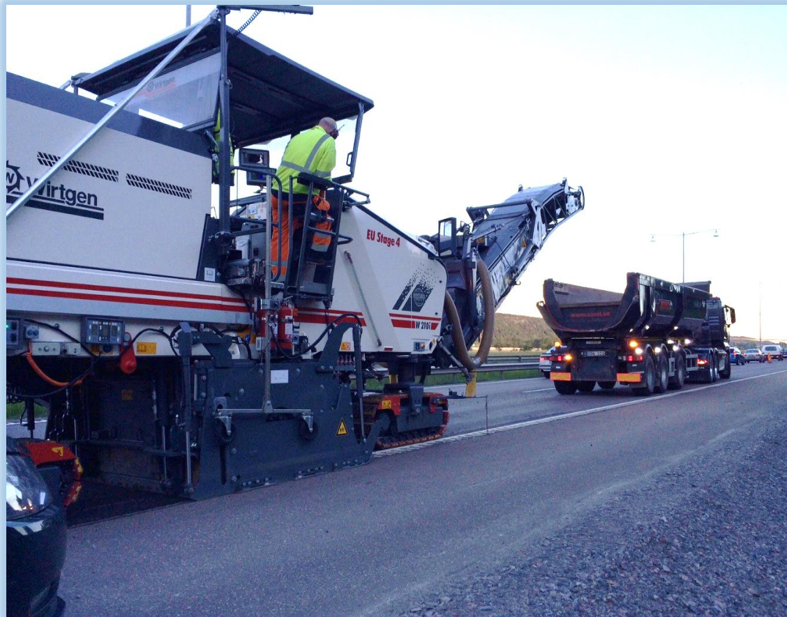
Figur 3, Fräsningsarbete norr om Göteborg
