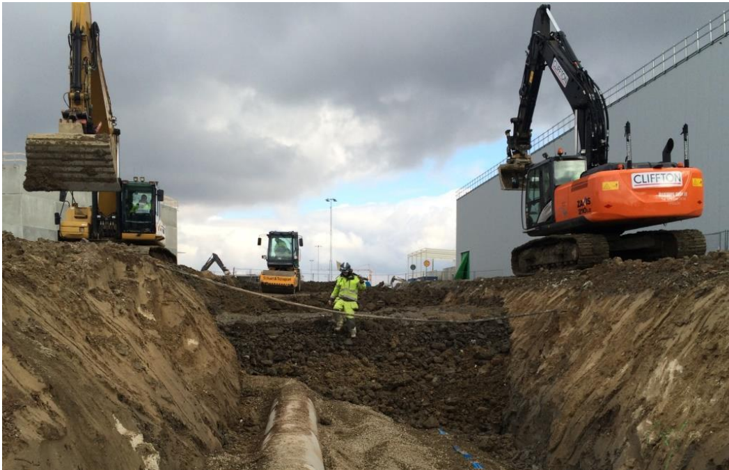
Figur 11. Arbetet med återfyll av stamledning med Cat 325 och Zaxis 210. Den tredje grävmaskinen kan skymtas i bakgrunden.
