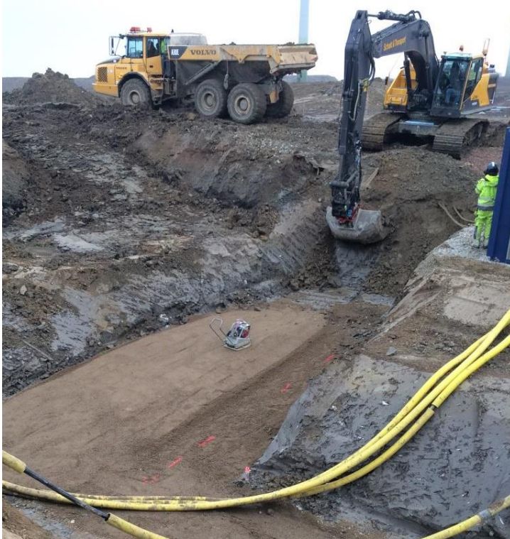
Figur 10. Foto på EC300 som schaktar ledningsgrav till pumphus. Dumper modell A30E kör iväg massorna. Observera schaktens storlek i jämförelse med vibratorplattan och anläggningsarbetaren.
