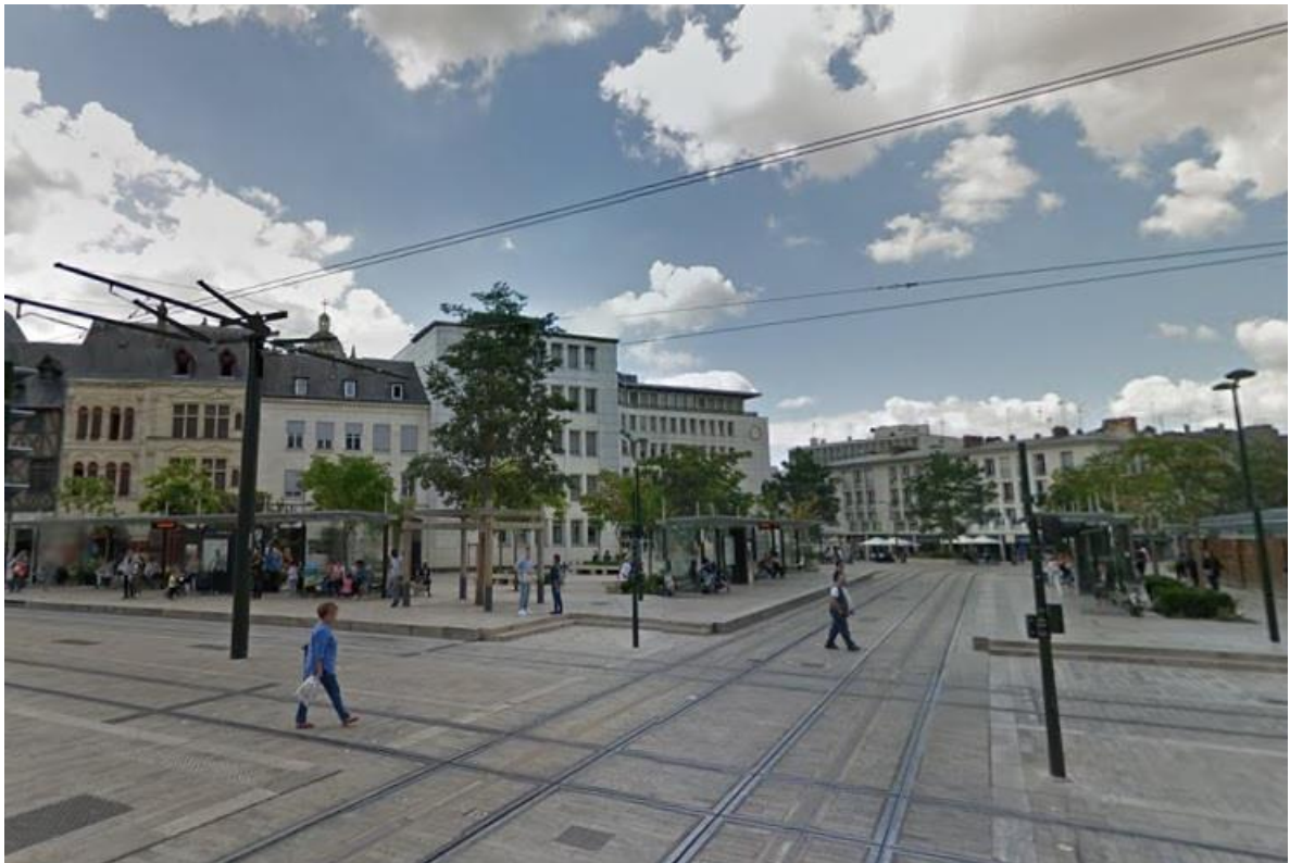
Figur 25. Kontaktledningsfri korsning i Orléans.
