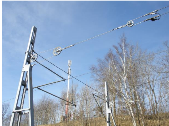
Figur 12. Viktavspänning. Lindhjul och utväxling.
