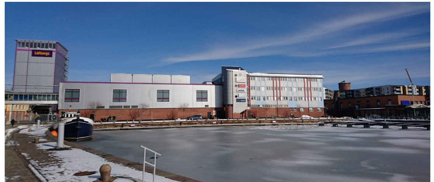
Skonertskeppet. Till höger Van der Brinks tillägg på byggnaden.
