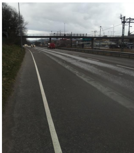
Figur 61 - Gång- och cykelväg intill högt trafikerad bilväg med höga hastigheter.
