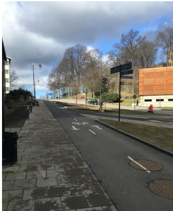
Figur 46 - Olika markbeläggning för gående och cyklister på en kortare sträcka
