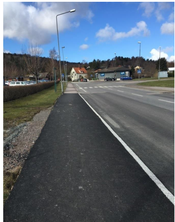
Figur 54 - Smala cykelfält, där markeringarna bitvis är borta
