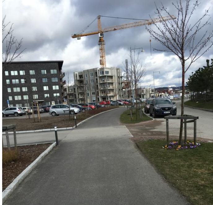
Figur 45 - Exempel på en nybyggd kombinerad gång- och cykelbana
