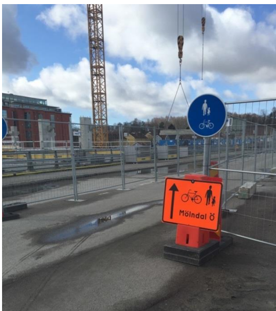
Figur 58 - Vägvisning vid vägarbete
