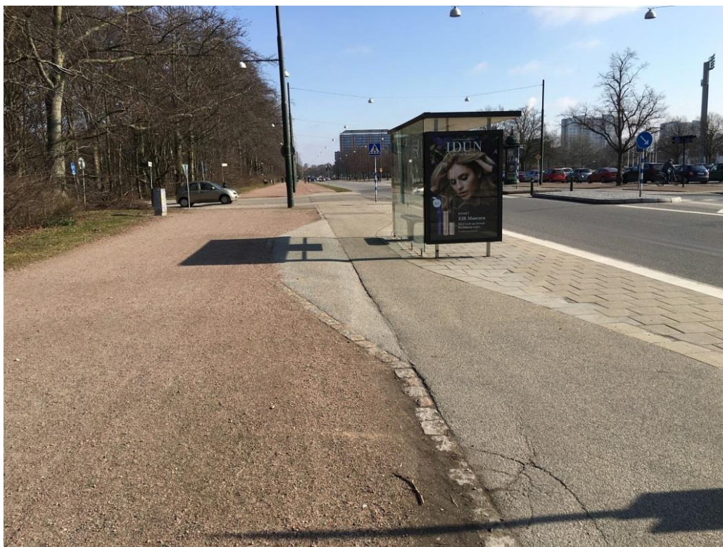
Figur 29 - Cykelbana dragen runt busskur, där cyklister får cykla över en besvärlig kant.
