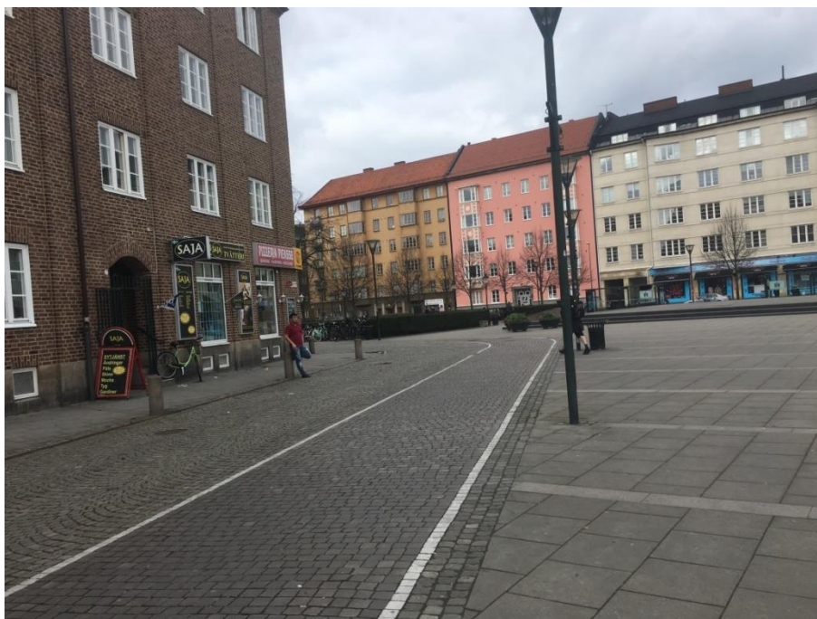
Figur 22 - Cykelväg på Värnhemstorget, utförd med slät gatsten.
