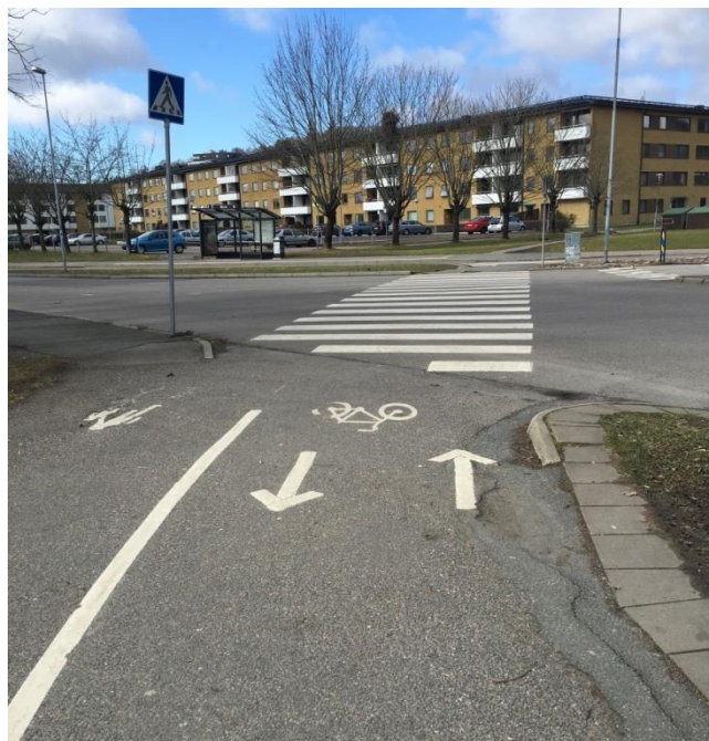
Figur 51 - Cykelväg som leds ut mot ett övergångsställe
