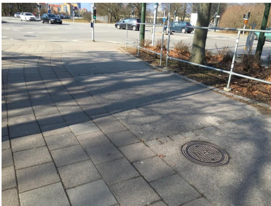
Figur 31 – Försök till uppmärksamhetshöjande farthinder i form av gatsten för cyklister inför korsning.
