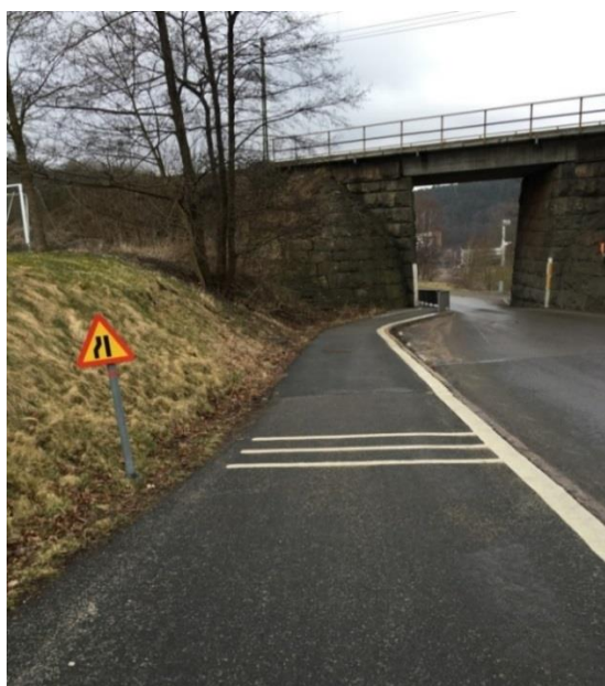
Figur 60 - Varning inför mycket smalt parti under bro
