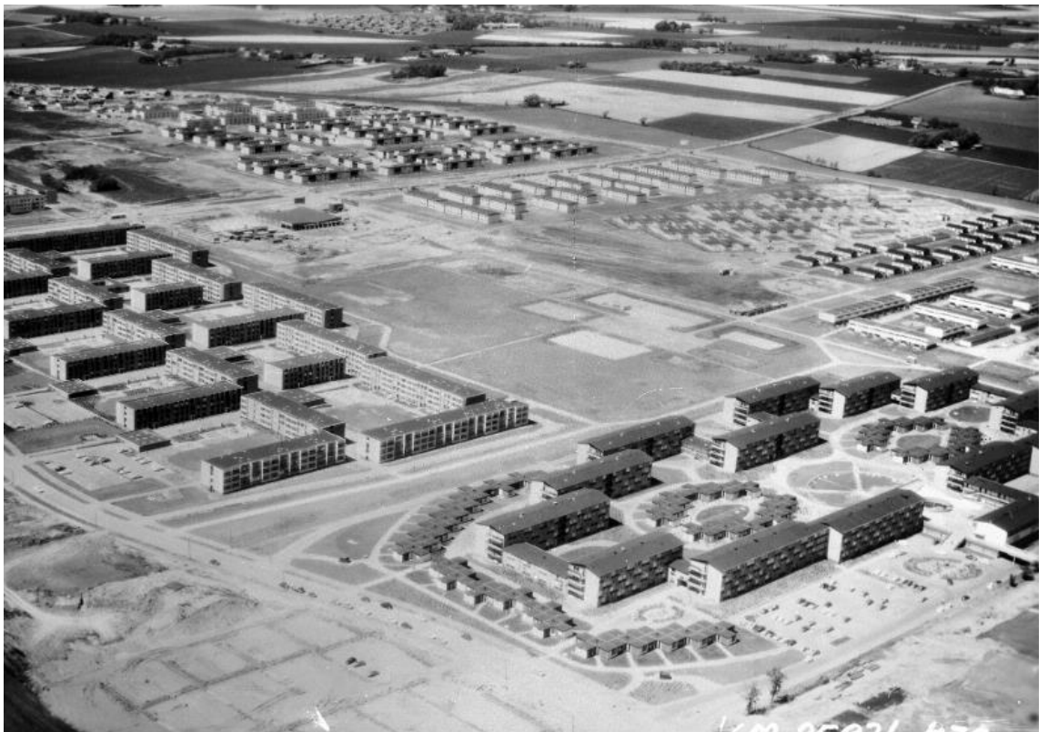
Norra Fååden under construction 1969 (Kulturen, 2016)
