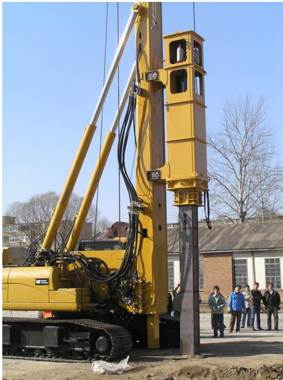
Figur 1-4 Betongpåle slagen med hammare
