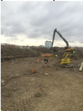
Figur 12: Massor fördelade på lastbil och på en sida om schakten (Fotograf: Viktor Bengtsson)
