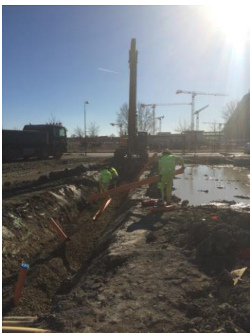
Figur 13: Grävmaskinen schaktar samtidigt som rörläggarna lägger rör (Fotograf: Viktor Bengtsson)
