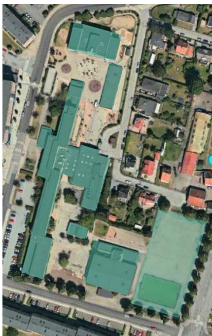
Figur 59. På Söderkullaskolan föreslås gröna tak på samtliga skolbyggnader och en översvämningsyta på bollplanen.
