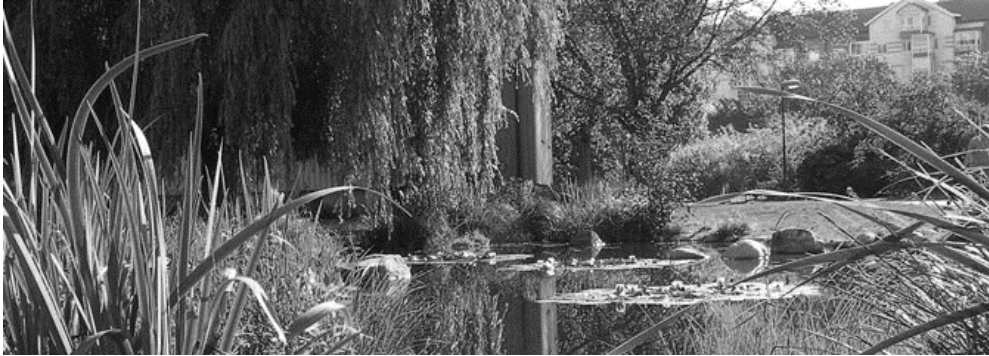
Figur 21. Damm i Augustenborg (VA SYD, 2016A).
