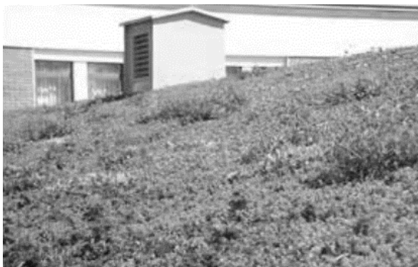
Figur 13. Anlagt sedumtak (Uppsala Vatten, 2014).
