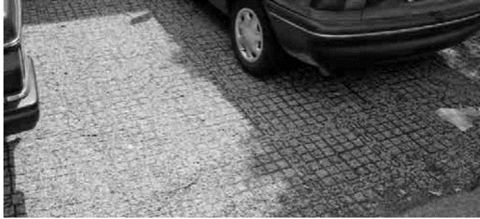
Figur 17. Permeabel parkeringsyta med ett stabiliserande rasternät för singel (Stahre, 2008).
