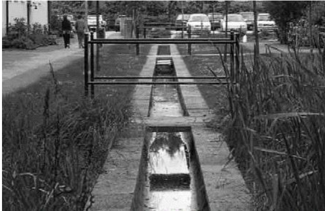
Figur 19. Kanal i Augustenborg, Malmö (Stahre, 2008).
