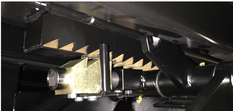
Figur 2.3, befintlig sjunkspärr med kuggsegment som sitter monterad på undersidan av ovanplanet för ett lyftbord. Ett matchande kuggsegment tar upp all last från lyftbordet.
