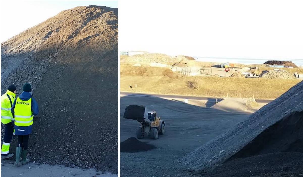
Figur 15. T.v. Den stora efterlagringshögen (4000 ton), ungefär åtta meter hög. T.h. Uppläggnig av den mindre testhögen (20 ton) bredvid den stora efterlagringshögen.
