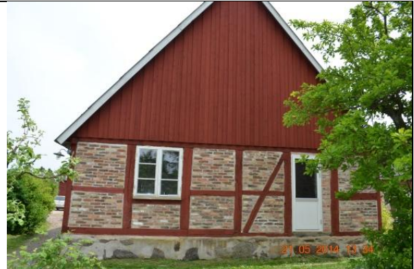
Bild 19 Renoverade fasaden, Foto framtagen av författaren av examensarbetet
