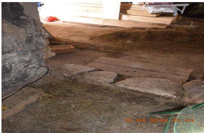
Bild 7 Grunden, gjuten betong inomhus, Foto framtagen av författaren av examensarbetet
