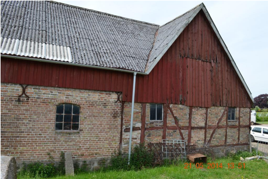
Bild 34 Eternittak, Foto framtagen av författaren av examensarbetet
