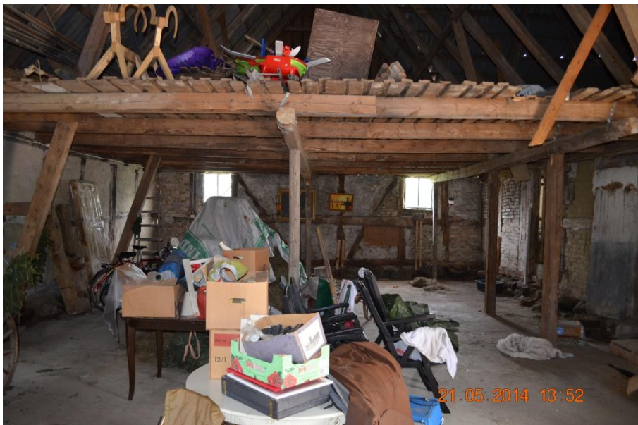
Bild 9 Insidan av stallet, Foto framtagen av författaren av examensarbetet
