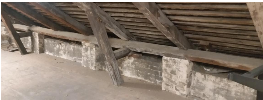
Figur 5-14: Kantbalken vilar på murpelarna.
