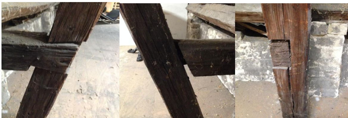
Figur 3-10: Foto på förband mellan stödben och dragsträva
