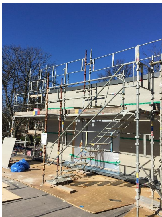
Figur 1: Exempel på ställning som fungerar som fallskyddsräcke intill takfot
