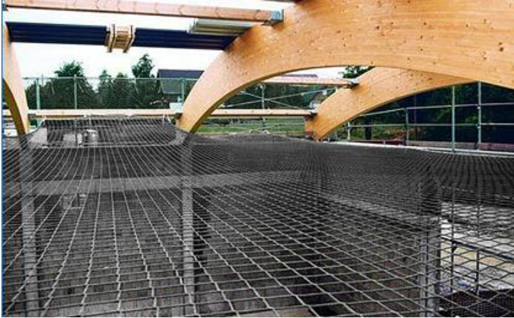
Figur 6: Skyddsnet uppspänd för att skydda mot fall. Källa: Invalid source specified.
