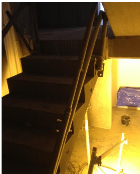
Figur 16: Nedfällt fallskyddsräcke intill trappa på ett av de besökta projekten
