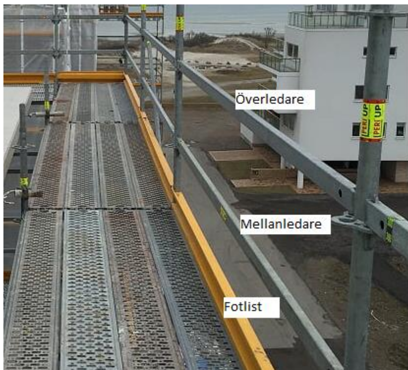
Figur 2: Ställning med monterat skyddsräcke
