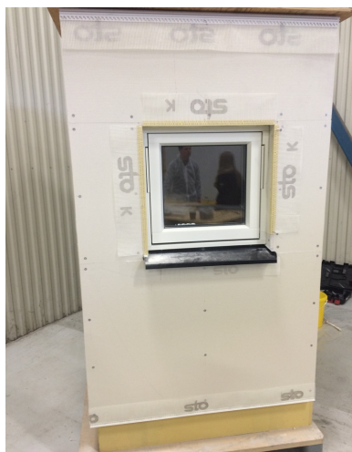
Figur 13 - Montering av armeringsnät
