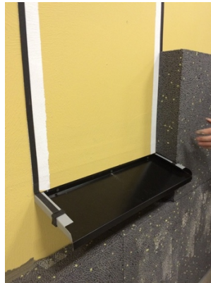
Figur 15 Montering av dränerande, putsbärande isolering
