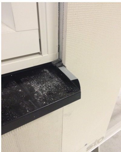
Figur 12 - Montering av fogband
