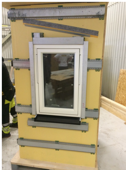
Figur 11 - Montering StoVentec-skivor
