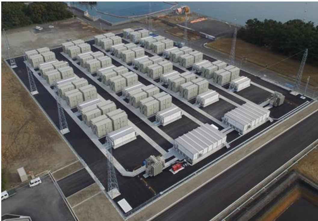
Figur 22. Världens vid tillfället största natrium-svavelbatterianläggning är placerad i Buzen, Japan med en effektkapacitet på 50 MW och en energikapacitet på 300 MWh (DOE, 2016).
