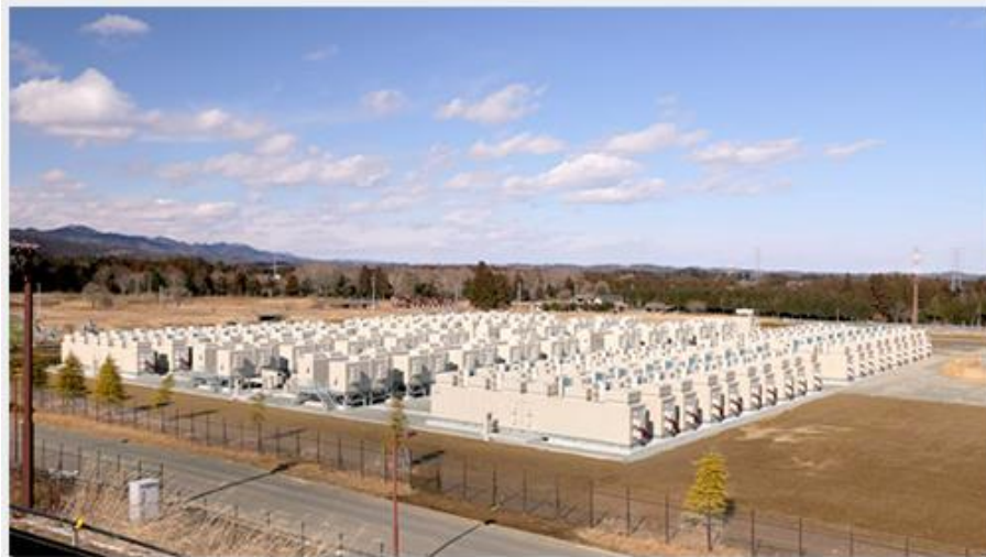
Figur 24. Den nuvarande största litiumjon-batteri-anläggningen i Fukushima, Japan. Den installerade effektkapaciteten och energikapaciteten är 40 MW respektive 40 MWh (Toshiba, 2016).
