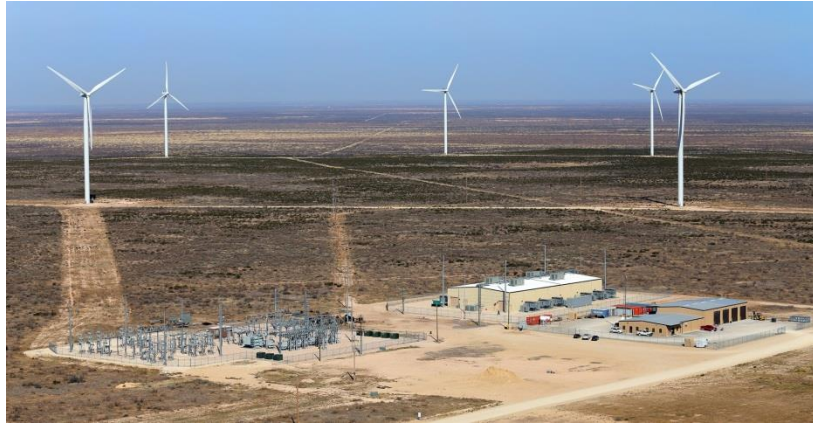
Figur 17. Ett batterilager med avancerade blysyra-batterier med effektkapacitet på 36 MW och energikapacitet på 27 MWh. Ligger i Goldsmith, Texas (Duke-Energy, 2016)
