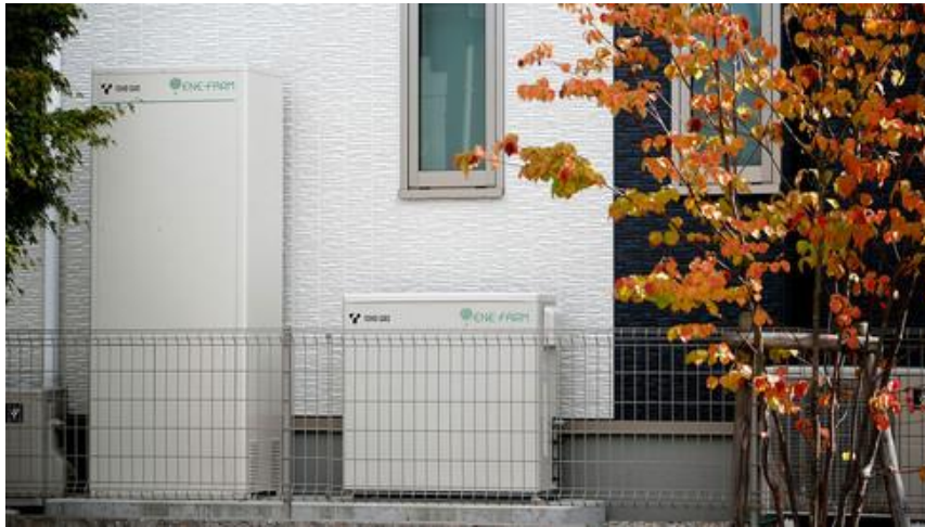
Figur 27. En installation av vätgaslagring för hushåll. Värt att notera är att detta system bygger på naturgas, principen bakom kan ses i figur 15 (Ene-Farm, 2016).
