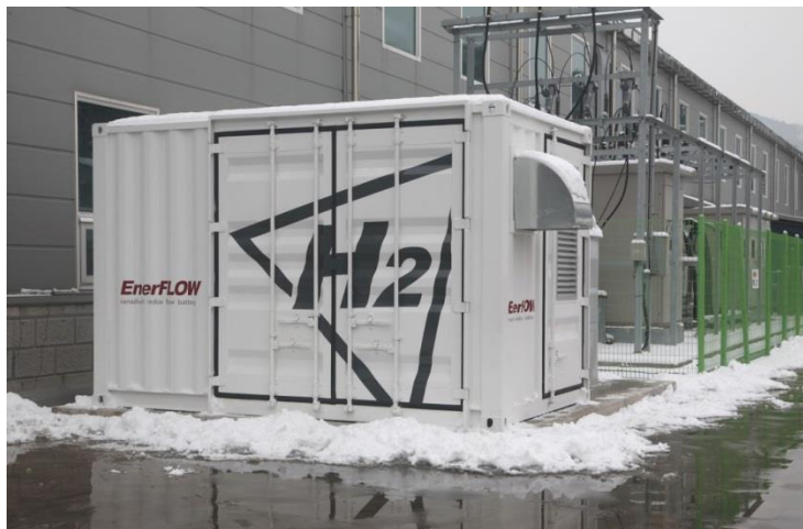
Figur 19. Ett flödesbatteri tillverkat av Enerflow med effektkapacitet på 50 kW och energikapacitet på 100 kWh, installerat i Gongju, Sydkorea (DOE Global Energy Base, 2016).
