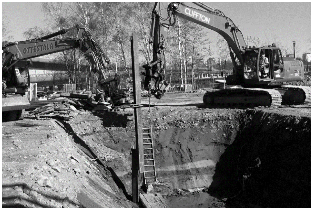
Bild 2. I bild sätts sponten på plats.
