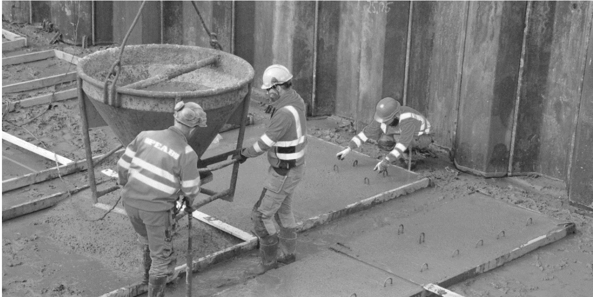
Bild 3. I bild gjuts platta 4.
