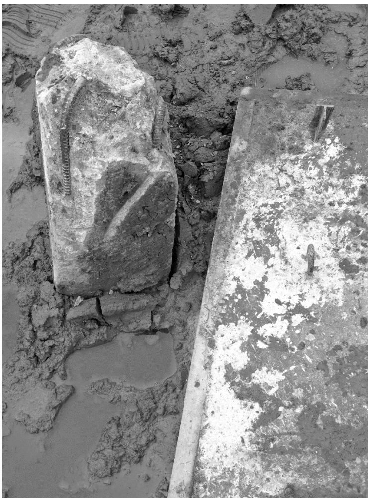
Bild 14. Pålen som sticker upp precis bredvid krypförsöksplattan.
