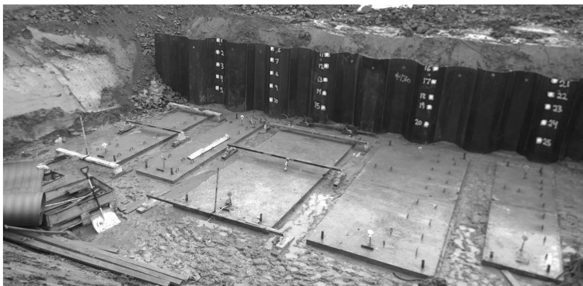
Bild 4. Färdiggjutna plattor i botten på schakten.
