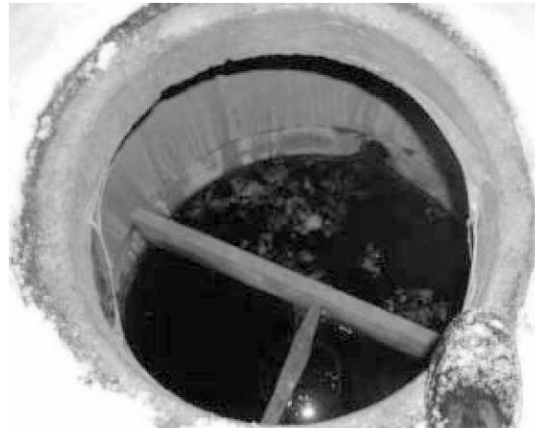
Figur 10: Slamavskiljare i form av en trekammarbrunn. Bilden är hämtad från Naturvårdsverket (2008) med tillstånd från bildens ägare.
