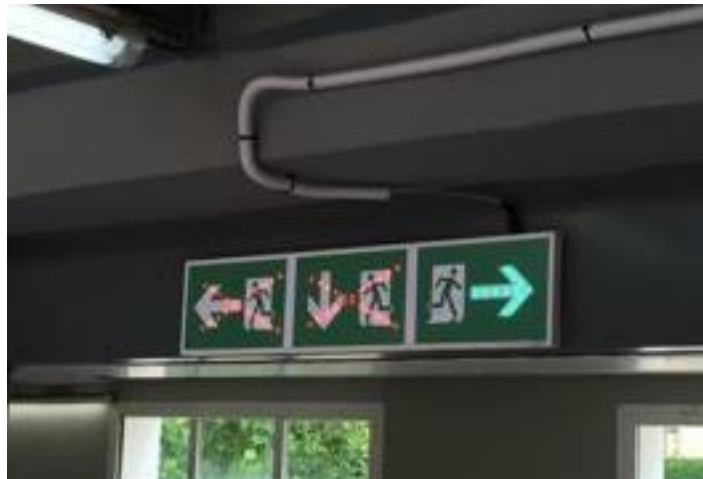
Figur 3. Exempel på utrymningsskyltarnas design och placering i försöket på tågstationen Sant Cugat i Barcelona. Intill en avvisande skylt placerades en vägledande skylt. De två skyltarna till vänster är överkryssade. Tillstånd av Galea (2016).
