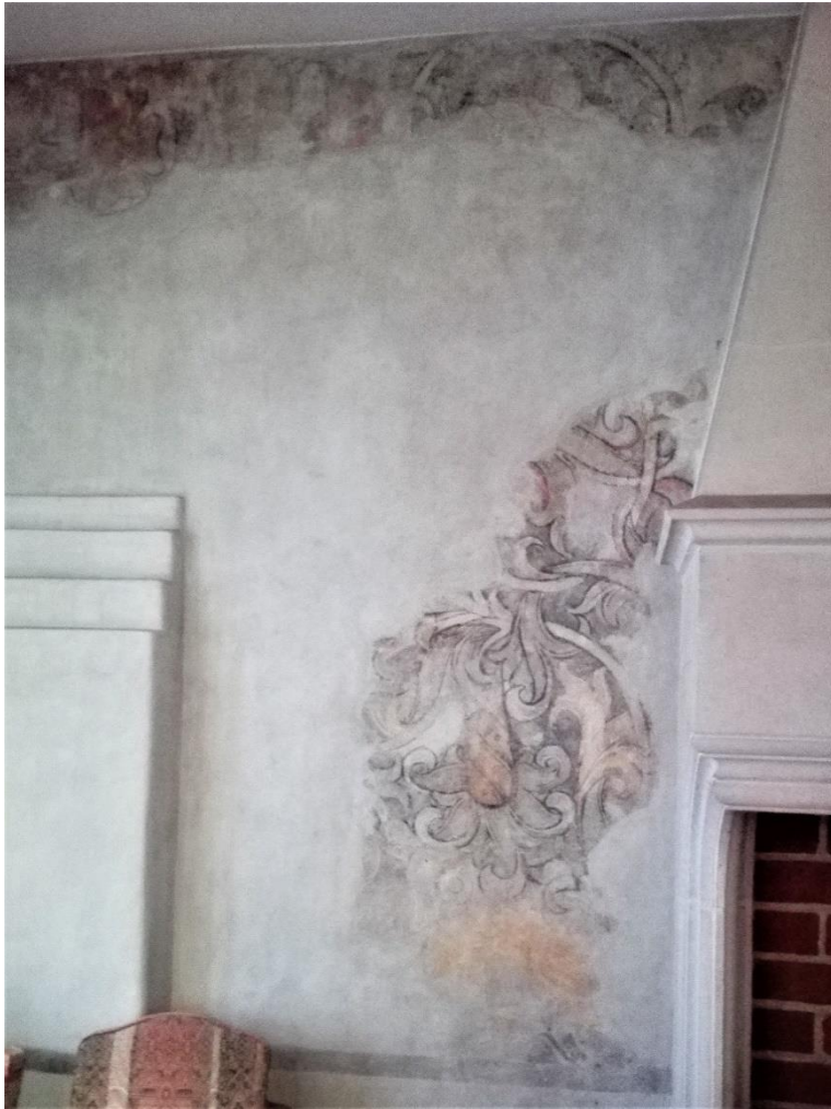
Fig. 13. Spår av ursprunglig kalkmålning och rekonstruerad spisel.
