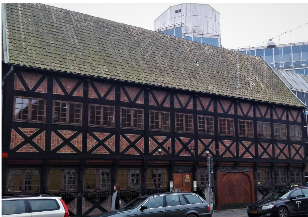
Fig. 14. Det Thottska husets västra fasad, ut mot Östergatan. Foto: förf. december 2016.
