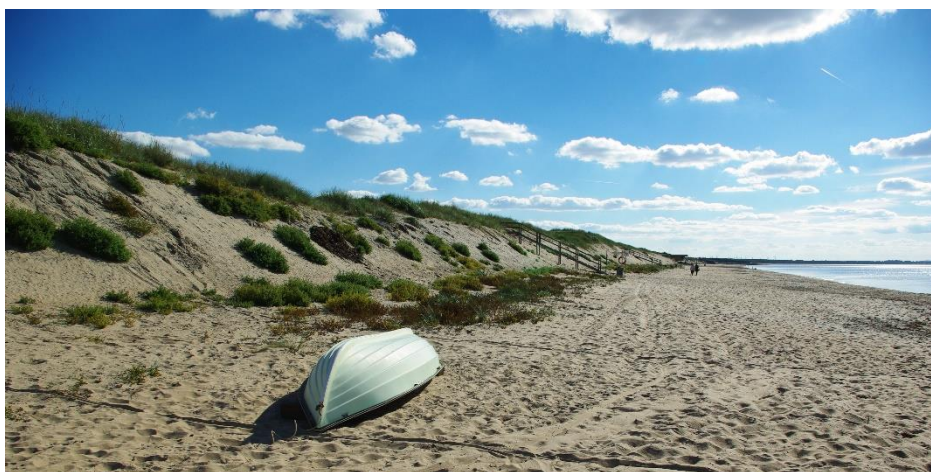
Figur 15. Artificiella frontdyner längre norrut på Ängelholms strand. Dynerna är fodrade, det vill säga att sand har fyllts upp mot erosionsbranten.
