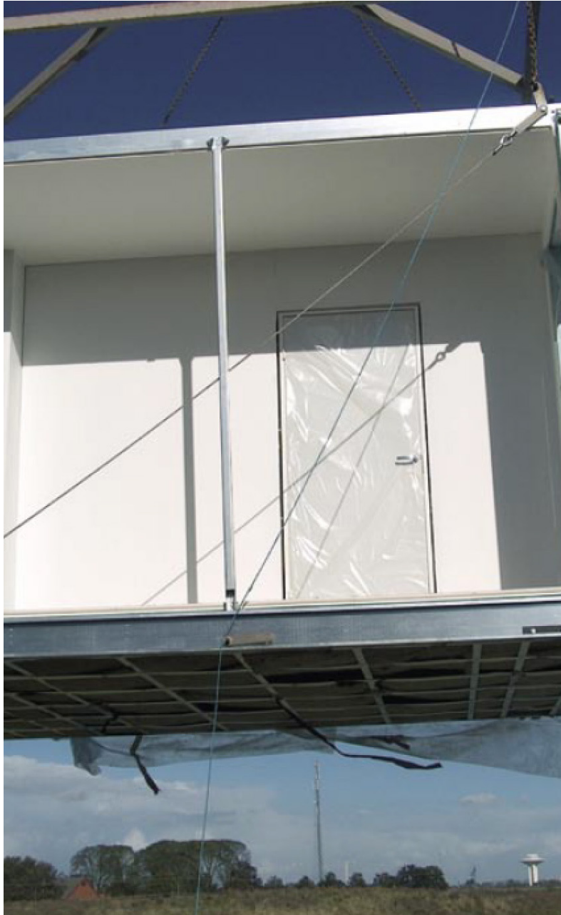
Bild 7, Volymelements lyft på plats (Boverket 2006)
