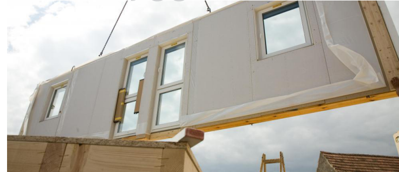
Bild 8, Färdigt väggelement (Next home u.å.)
