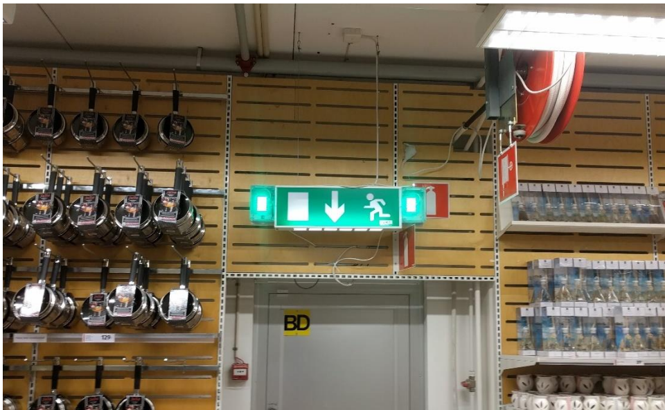
Figur 13. Installation av dynamiskt system vid försök i anslutning till kassorna.
