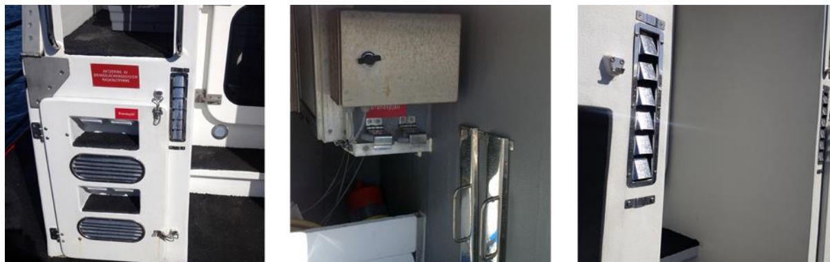
Figur 2.3. Förvaringsutrymmet på akterdäck och anordningar för att stänga ventilationen och aktivera släcksystemet.
