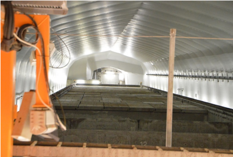
Figur 3 - Bild inifrån BMA, När BMA är fullt kommer ett lock i betong att gjas på plats - Bilden används med tillstånd från SKB
