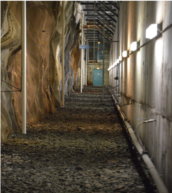
Figur 4 - Mellanrum mellan bergvägg och betongkonstruktion som kommer att fyllas med makadam - Bilden används med tillstånd från SKB
