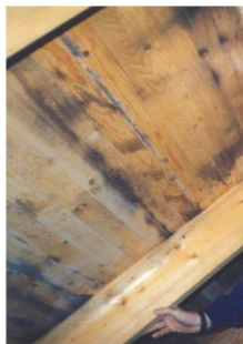
Figur 4.8. Fukt eller smutsansamling på vindstak
