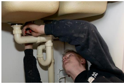
Figur 3.2 svårighet vid montering av klämringsskoppling i trånga utrymmen
