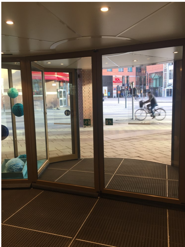
Figur 9: Utrymningsväg genom roterdörr med manuell öppning genom tryck vid händelse av brand.
