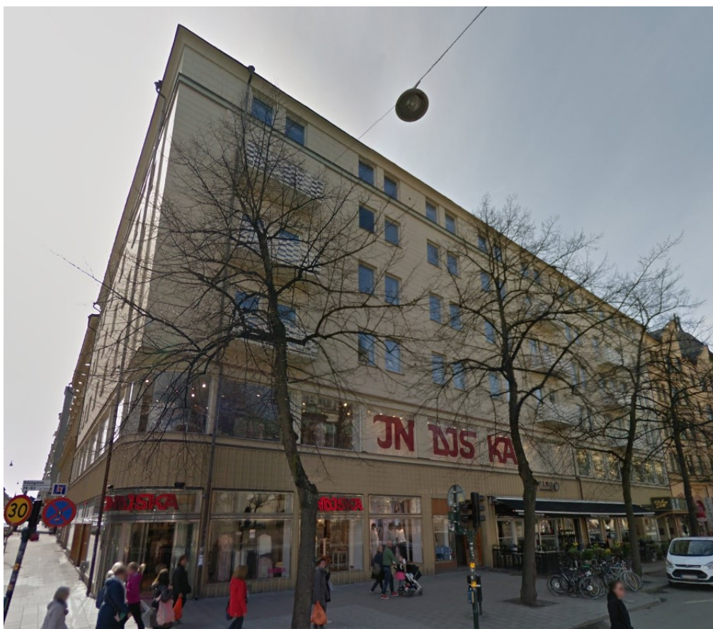
Figur 2. Byggnaden som är uppförd inom Stockholm Sirius 23 och 24. 67
