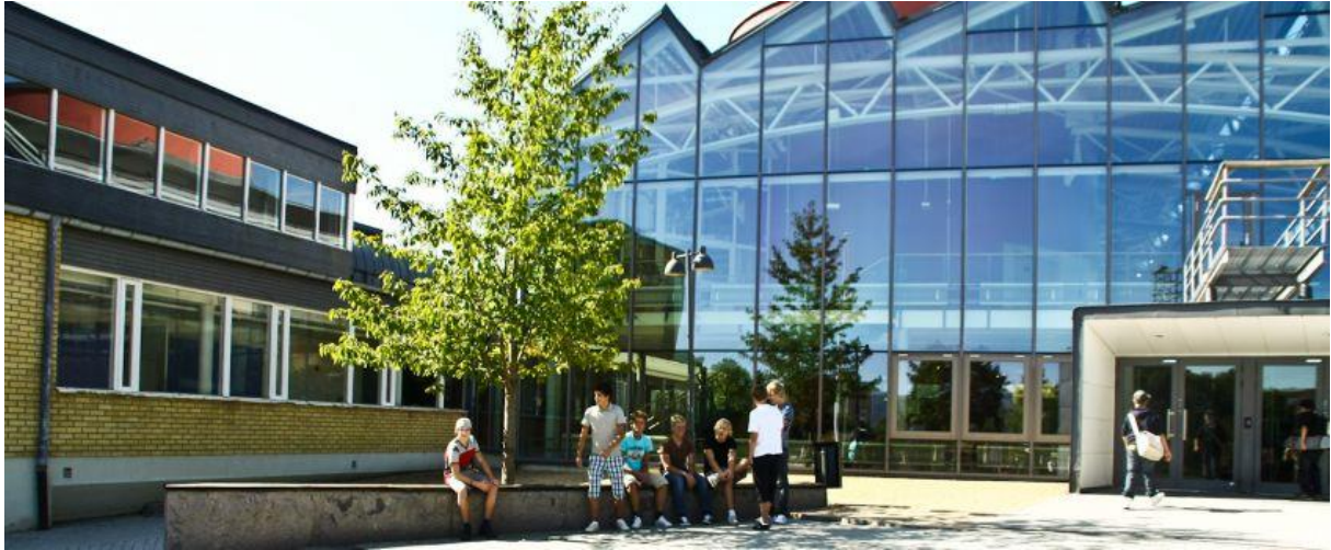
Figur 1: Bildningscentrum i Flen efter ny- och ombyggnation. Huvudentrén till gångstråket syns till höger i bilden. (Bild med tillstånd från Flens kommun)
