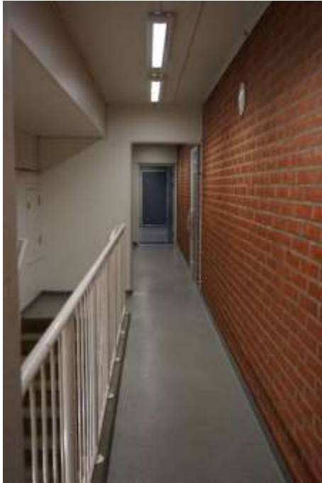
Figur 11 Bild av korridor utanför omklädningsrum intill ishall samt trappan som leder ner till plan 1.
