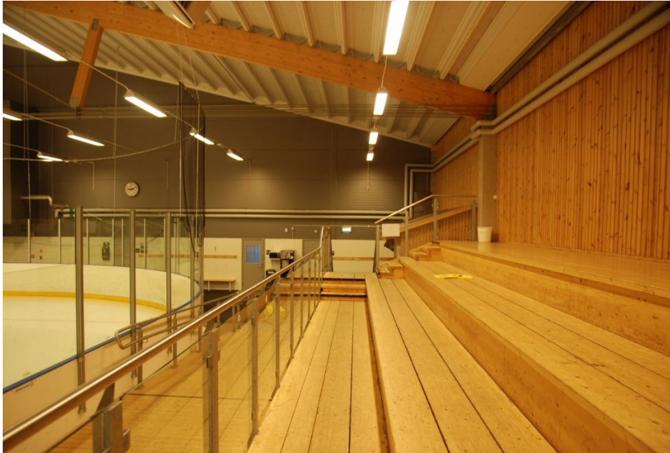
Figur 4 - Del av läktarens norra sektion.
