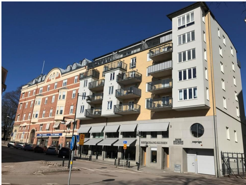
Bild 4.1: Den färdigställda våningspåbyggnaden på fastigheten Gruvan 1 längst till höger i bild. De två nedersta våningarna var befintliga och de fem ovanliggande byggdes på.
