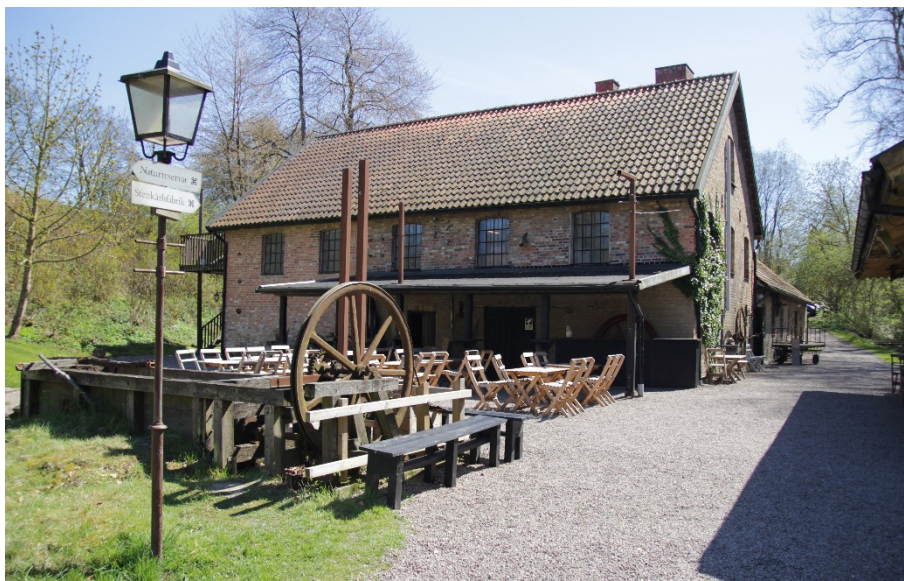
Figur 1.1: Wallåkra stenkärleksfabrik - fabriksbyggnad
