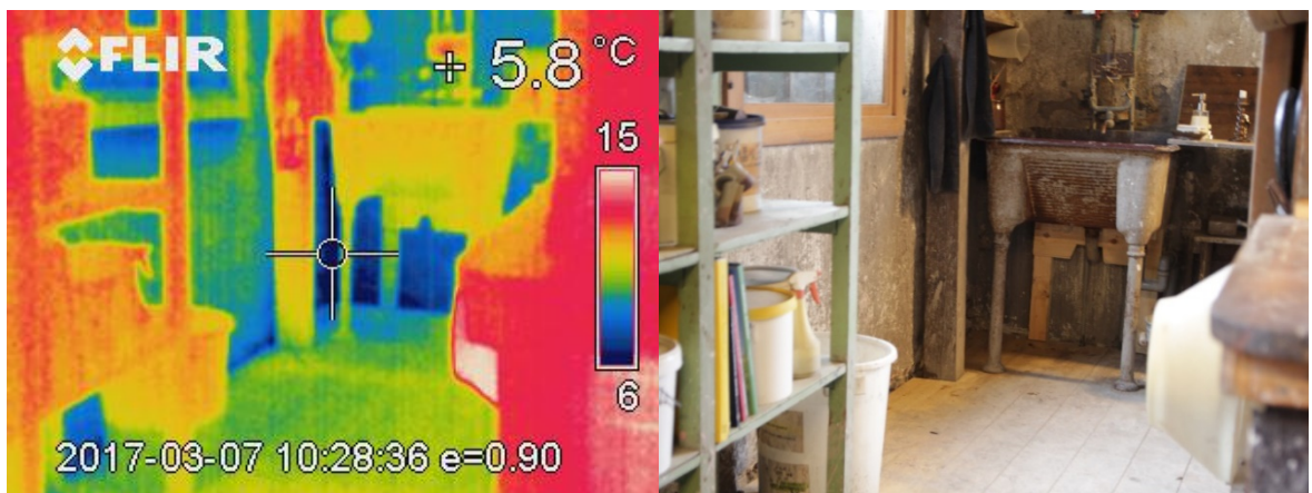
Figur A.3: Anslutning vägg-vägg och vägg-golvbjälklag.
