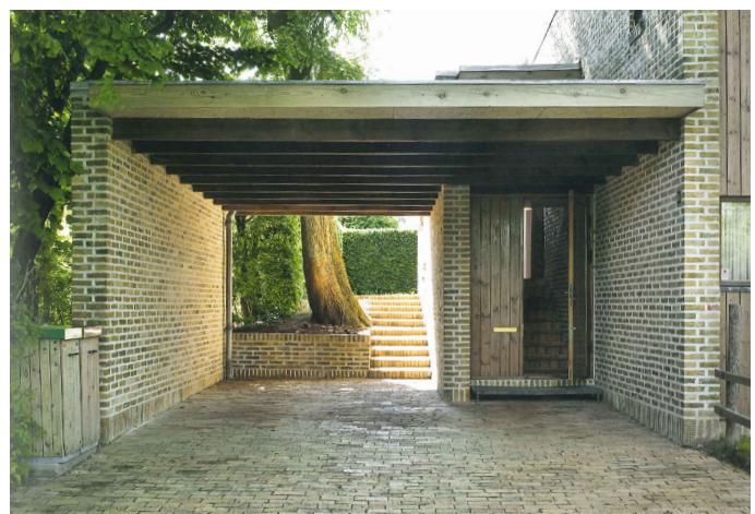
Bild 15, Carport och entré, taket har tvärgående balkar exponerade
