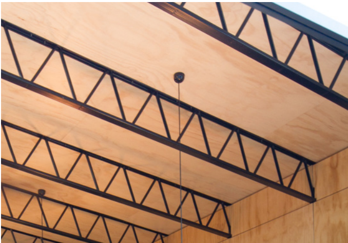
Bild 17, Exponerade fackverksbalkar i stål, Hello House av OOF! Architecture
