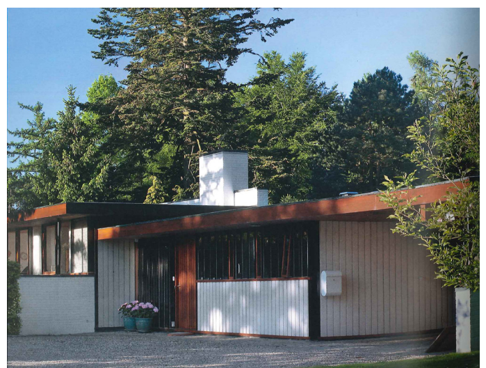
Bild 10, framsida, entré och carport
