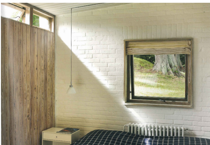
Bild 14, Sovrum, 'gavelvägg' med panel och fasadvägg i putsat tegel
