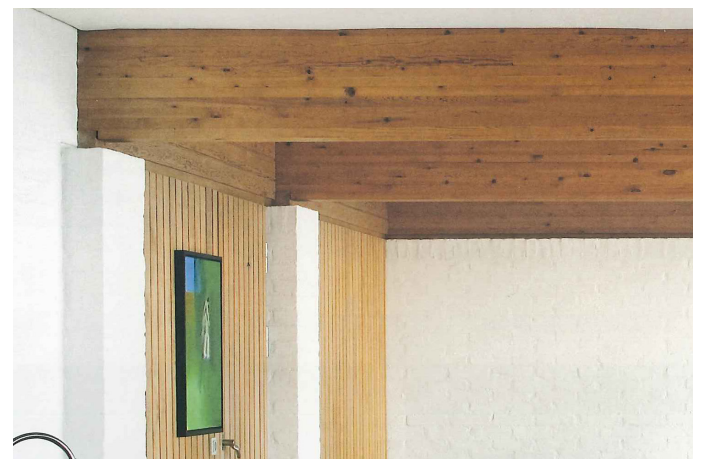
Bild 5, Limträbalkar möter tegel mur i vardagsrum
