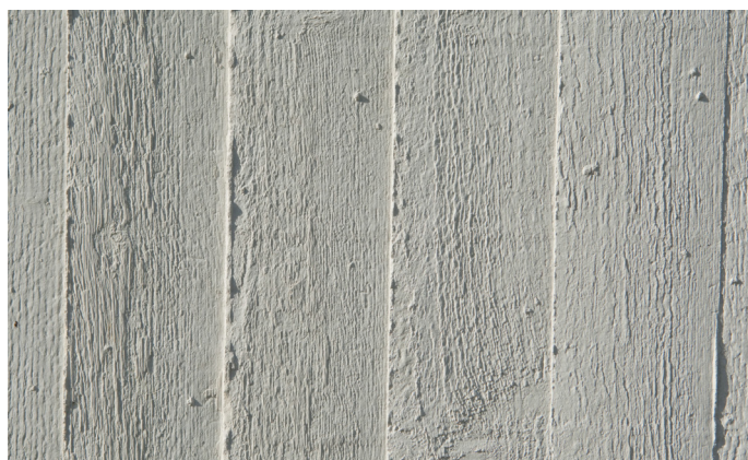
Bild 19, Betong med intryck från brädform av UBAB
