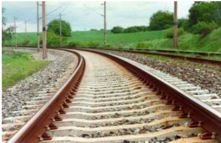
Figur 2 Ballastspår med sliprar och räl (Esveld, 2001)
