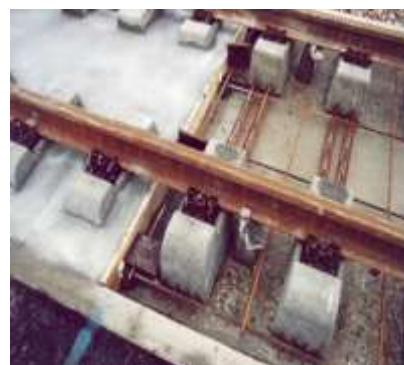
Figur 4 Twinblock med fackverksarmering (Esveld, 2001)
