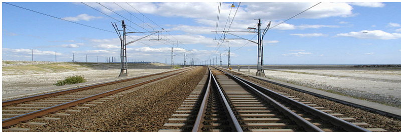
Figur 2. Ballastspår (källa: Järnväg, 2016).
