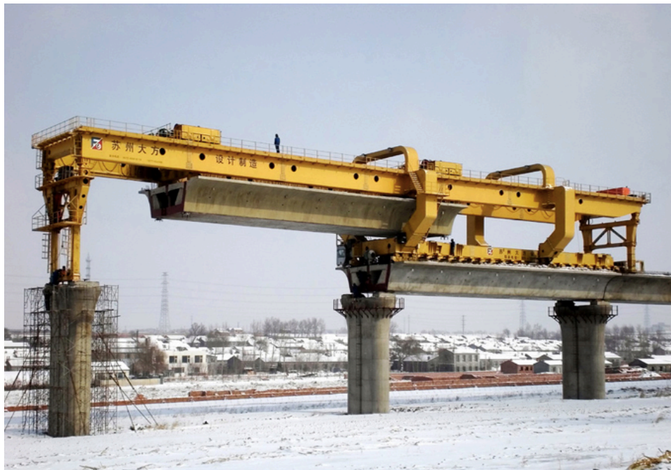
Figur 7. Alternativ lösning för utsättning av prefabbrodelar (källa: Robosoon, 2017).
