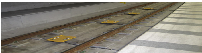
Figur 3. Slabtrack (källa: Trafikverket, 2016).
