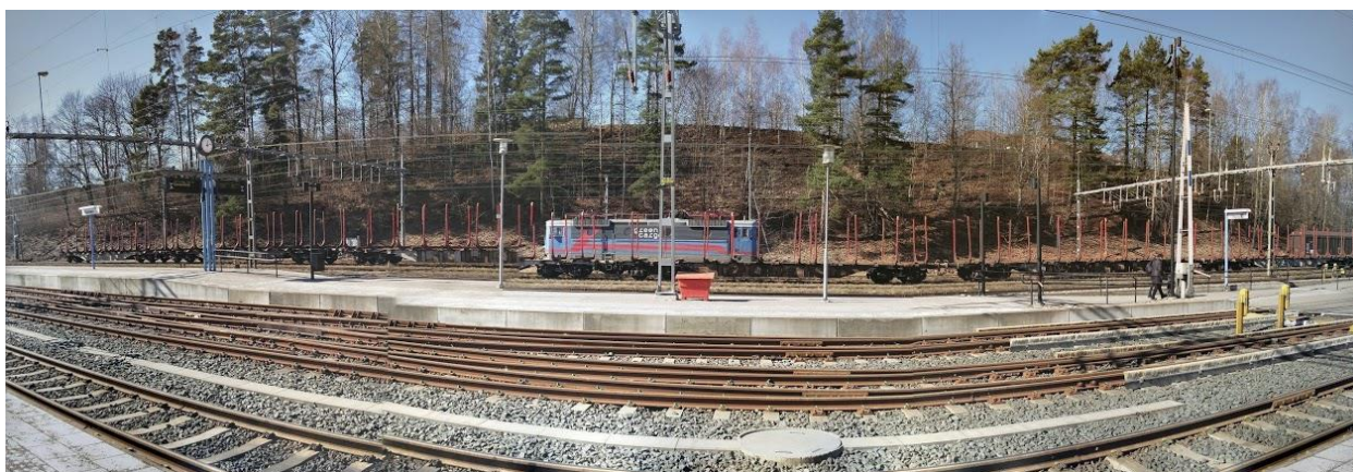
Figur 21 Panorama foto av Värnamo station
