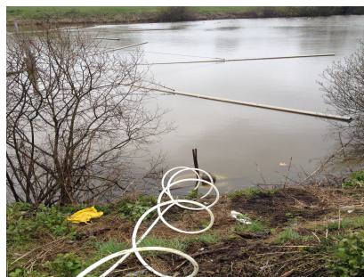
(d) Lakvattendammen används som värmelast.
