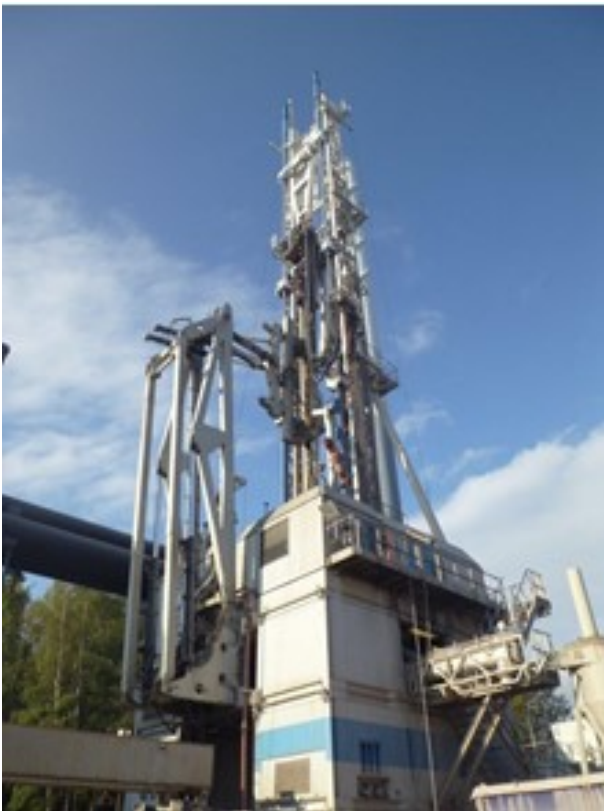
Fig. 11. Borrningen som använts i Espoo, Finland. Foto Rosberg (u.å.)
